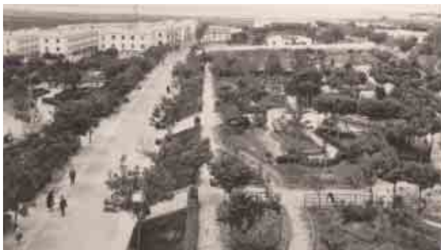
Espacio de interés urbano y singular, Nivel 1 - Parque Almirante Lauhlé.
